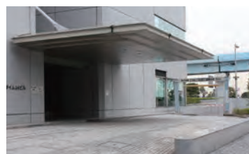
1階 荷捌き場・車寄せ
