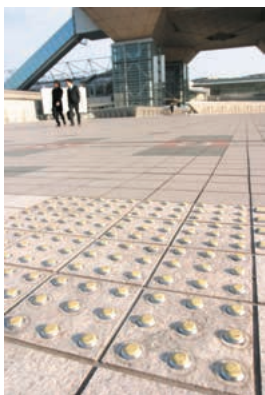
写真は、蓄光型点字ブロック。薄暗くなると、日中貯蓄した太陽光で明るく誘導してくれる。
