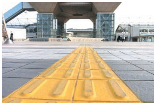
通常の点字ブロック。これまでよりも鮮やかな黄色になったことで、はっきりと分かるように。
