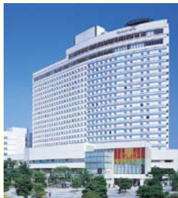
▲優良防火対象物として認定(有明パークビル)
