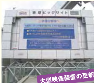
ガラス面シール張替・塗装
